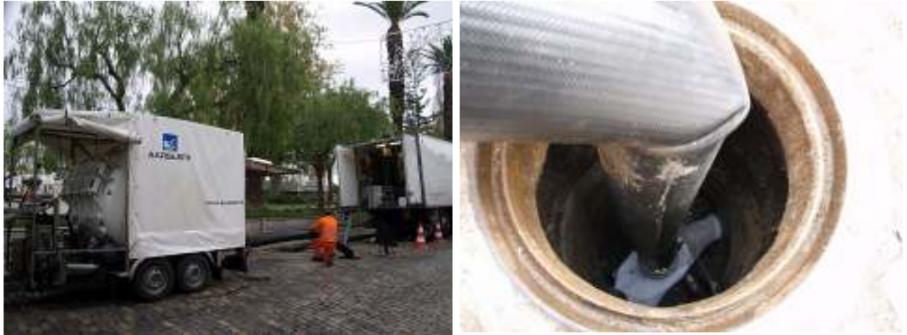
Imagem 1 e 2 – Reabilitação de coletores através da tecnologia Cured-In-Place Pipe (CIPP).
